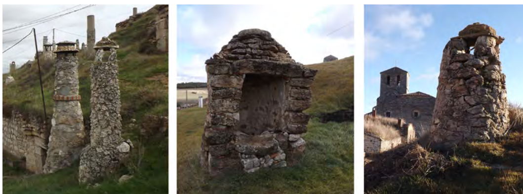
Figura 4. Vista de diferentes tipos de zarcas, a la izquierda esbeltas troncocónicas, centro y derecha desgarradas prismática y troncocónica respectivamente. Fuente: elaboración propia del autor (2014).
