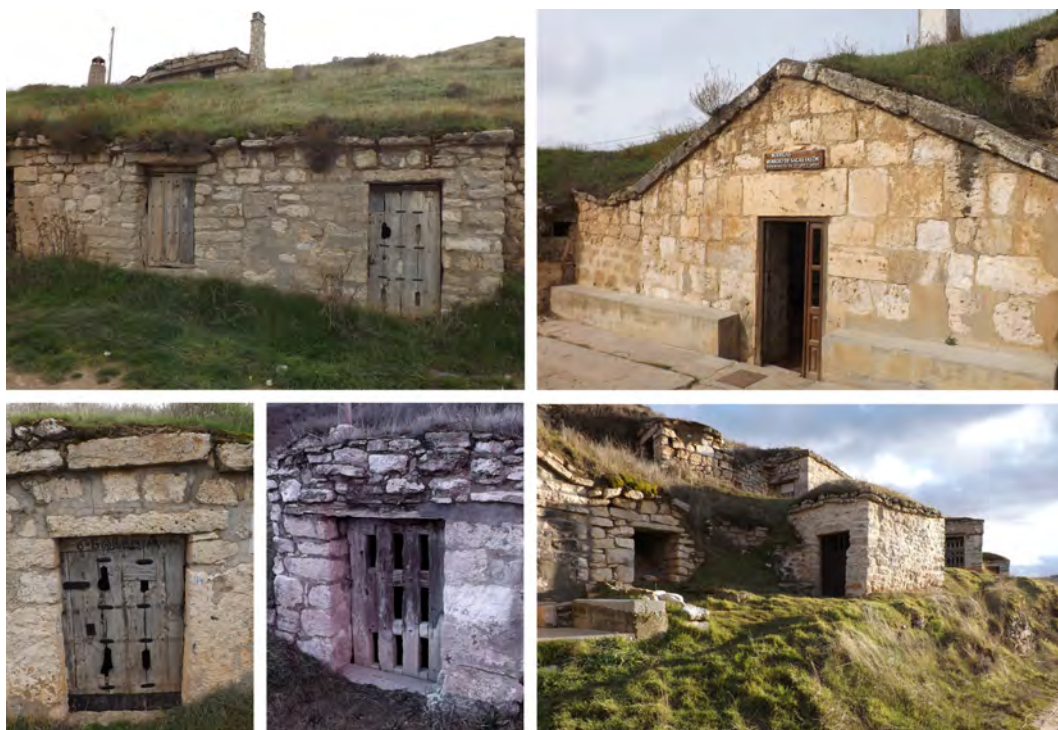
Figura 2. De izquierda a derecha, vista de bodegas de frente horizontal, vista de bodegas de frente triangular, vista de dos modelos de puertas tradicionales y vista de fachadas cúbicas, estas en Valdecañas de Cerrato. Fuente: elaboración propia del autor (2014).
